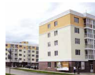
Жилой комплекс «Новый свет», г. Волгоград
