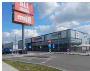
Строительный гипермаркет Mile, г. Минск
