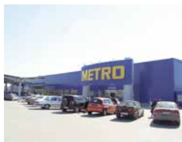
Торговый центр Metro, г. Пермь
