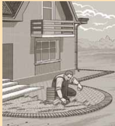
Укладка очередных рядов клинкерной брусчатки.
