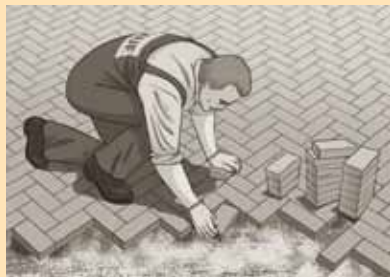
Мощение поверхности с формированием узора «елочка».
