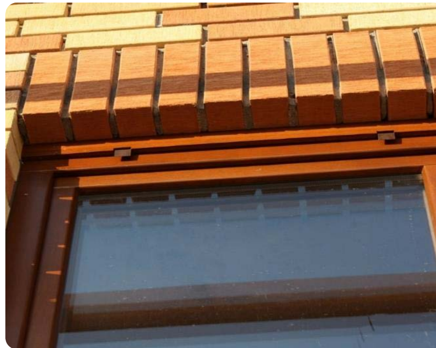
Внешний вид кладки с использованием закладных деталей BRICKO
