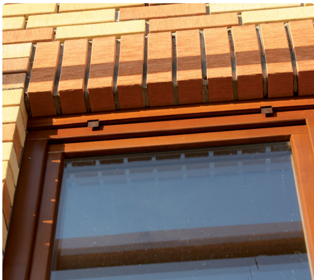
Внешний вид кладки с использованием перемычек BRICKO
