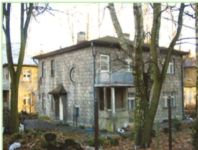
Здание из газобетона без наружной отделки. 1939 года постройки, г. Рига
