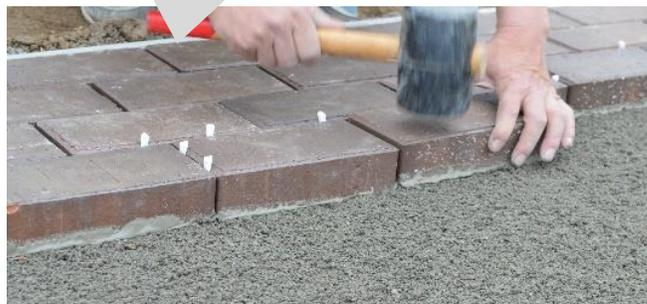
утапливание брусчатки на 5-15 мм в подстилающий дренажный слой.
