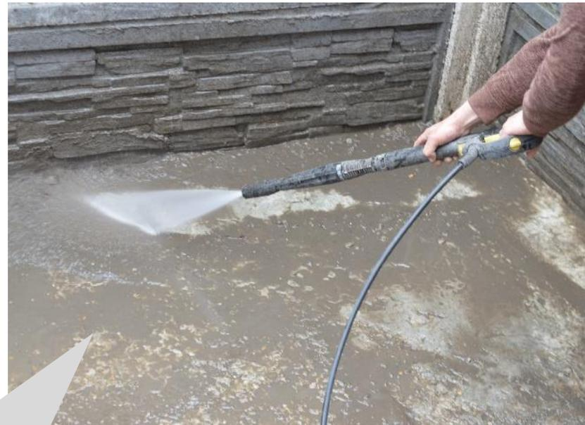
При необходимости выравнивания использовать цементные стяжки ОСНОВИТ. После очистки и просушки, рекомендуется прогрунтовать универсальным грунтом Утконт Стандарт LP51.
