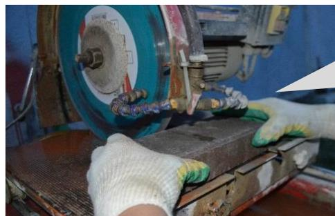
Резку осуществлять при помощи электрических плиткорезов, используя алмазные диски.
