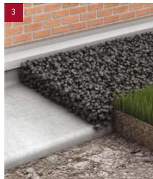
Сформируйте отсыпку песком переменной толщины с уклоном приблизительно 5% от стен дома и приступайте к укладке мембраны PLANTER Geo геотекстилем вверх. Для «стыковки» рулонов сформируйте нахлест минимум 5 см, отделив геотекстиль. Прижмите сформированный нахлест, чтобы «выступ плотно зашел в ячейку».
