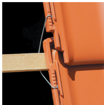
Die Fixierungskerben für die Sturmklammern.
