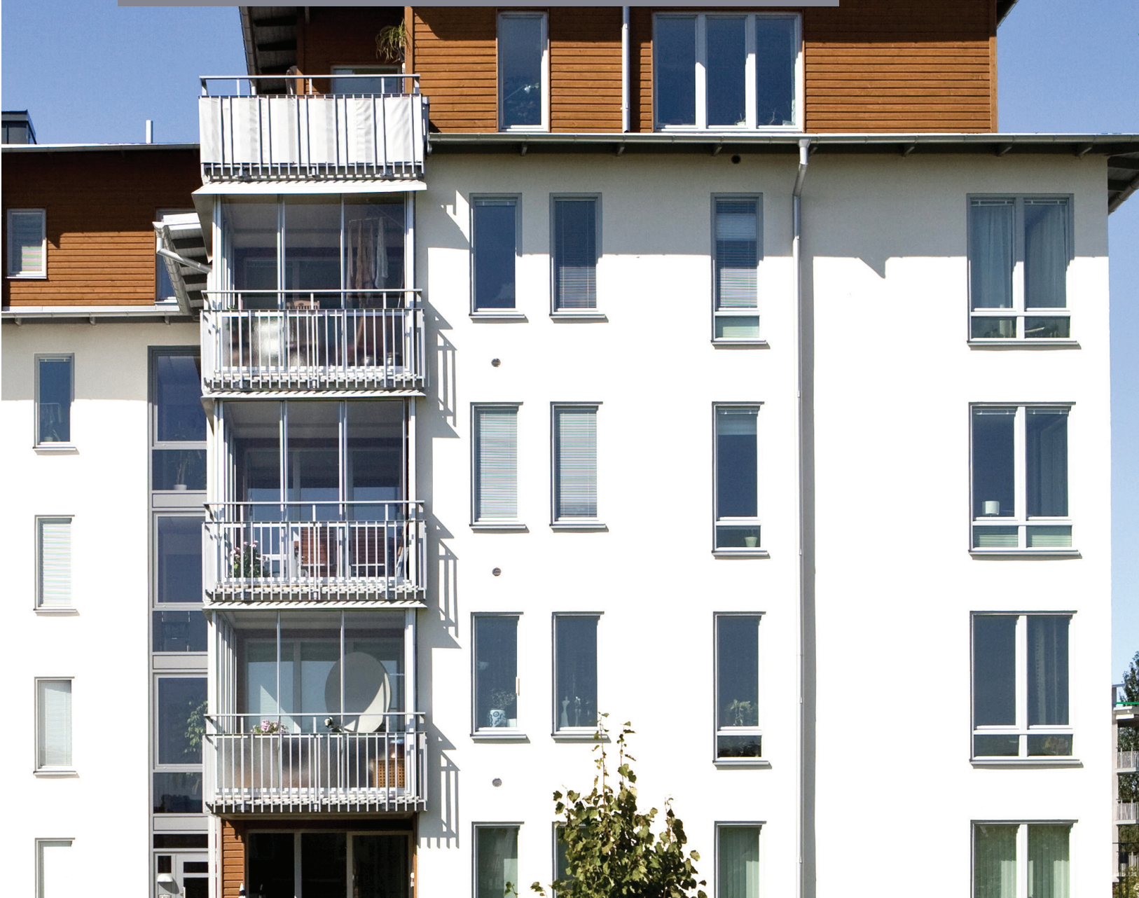
Декоративная штукатурка шуба ЭКСТЕРВЭЛЛ
