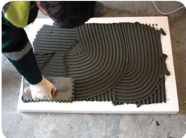
вплотную одна к другой. Зазор между плитами – не более 2-3 мм. Последующие работы по установке дюбелей и устройству базового слоя можно производить не ранее чем через 2-3 суток.
