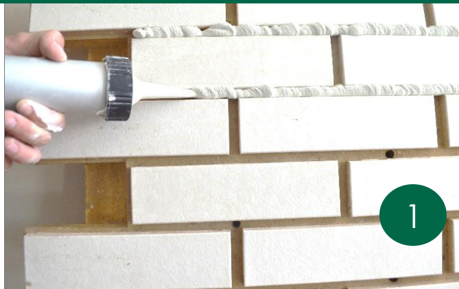
Заполнение горизонтальных швов
