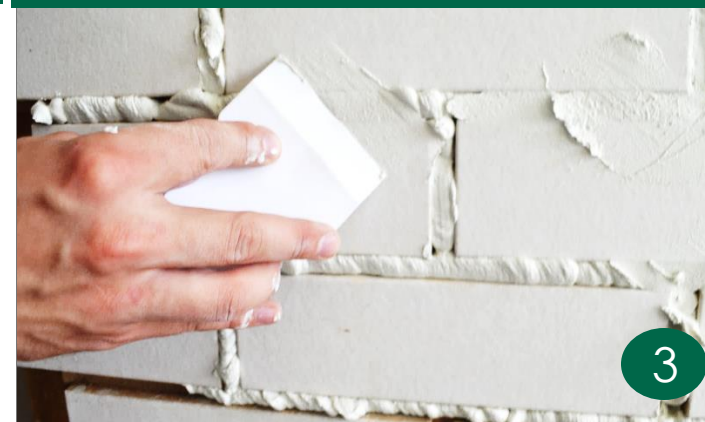
Уплотнение резиновым шпателем
